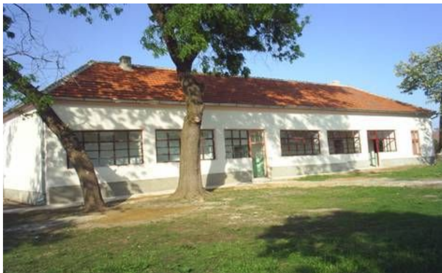
Locul punctului E-Maghiar dupa renovare
